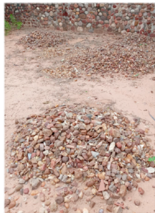
Restmateriaal om de terrasranden mee te verstevigen
